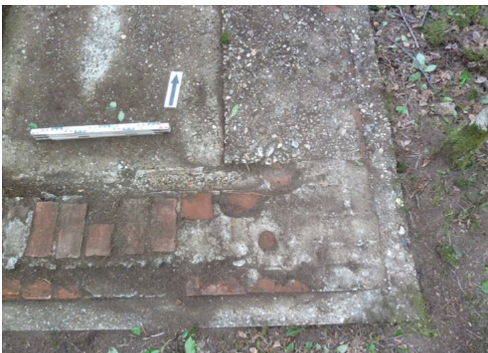
Afb. 9.12 Hoek van de betonplaat met gegoten randen en resten van muurwerk in rode baksteen (foto RAAP).
