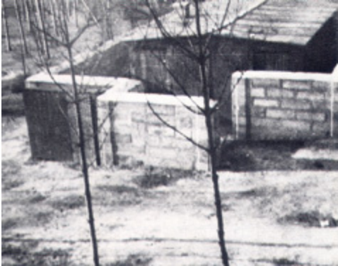
Afb. 8.10 Ingegraven barak met Splitterschutz muur, ter bescherming tegen scherfwerking van bommen en granaten, bij radiopeilstation Teerose bij Arnhem (bron Tiemens 1986).
