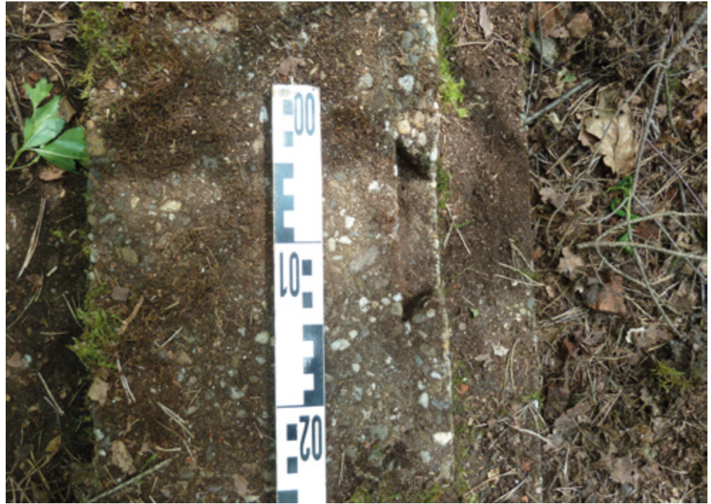
Afb. 9.13 Een van de vier trapeziumvormige uitsparingen aan de rand van de betonplaat (foto RAAP).
