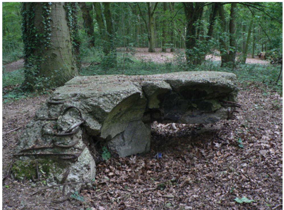
Afb. 6.2 De resten van een opgeblazen gietstalenkoepelkazemat (G16) op de Grebbeberg bij Rhenen (foto RAAP).
